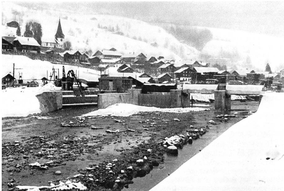
der übrigens bei der Oeffnung der Baugruben offensichtlich wurde, ist Rechnung getragen worden durch ein Drainagesystem auf beiden Ufern, welches das Hangwasser und das Verlustwasser der Stauanlage aufnimmt und unterhalb des Wehres der Simme zuleitet.
