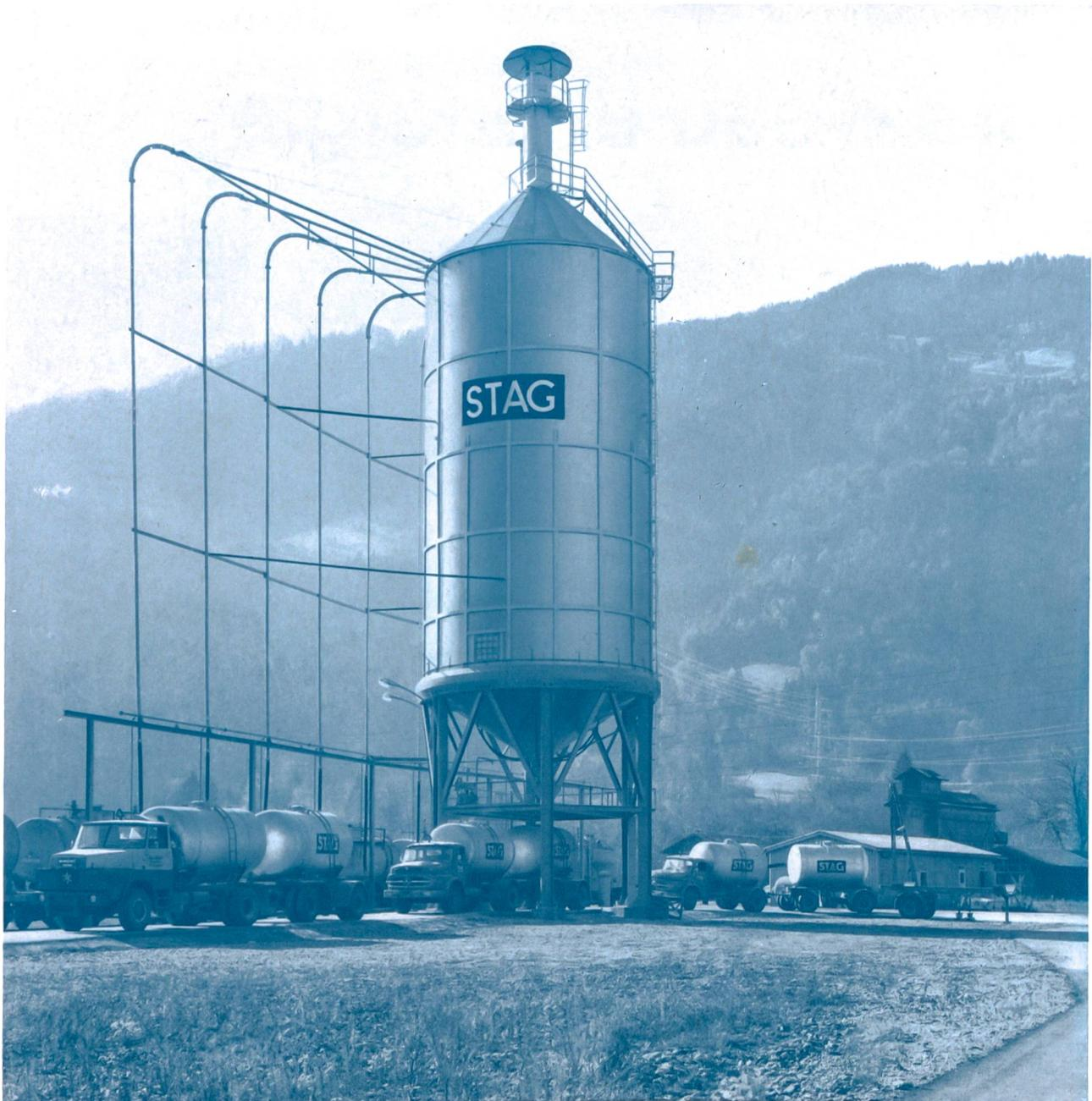
Umschlagsanlage der STAG in Vandans/Vlbg. mit Silo von 1600 t Fassungsvermögen.
