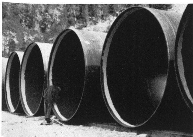
Teilstücke der Druckrohrleitung des Kraftwerkes Kaunertal auf der Baustelle nach der Innenbehandlung mit IMERIT.
