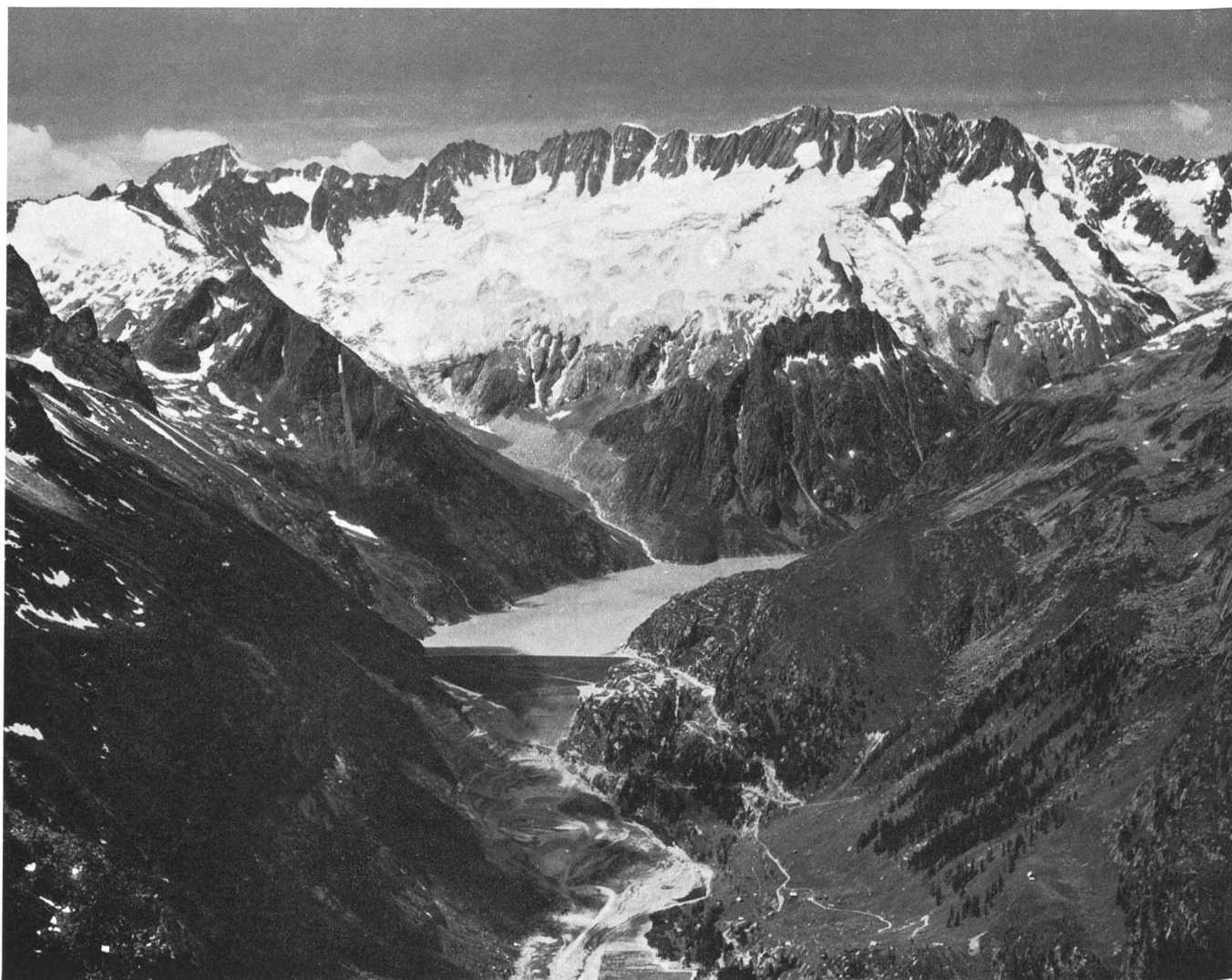
Staudamm und Stausee Göscheneralp des Kraftwerks Göschenen
