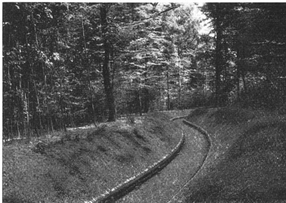
Fig. 1 Sickergraben zur Anreicherung des Grundwassers (Brodbeck)
