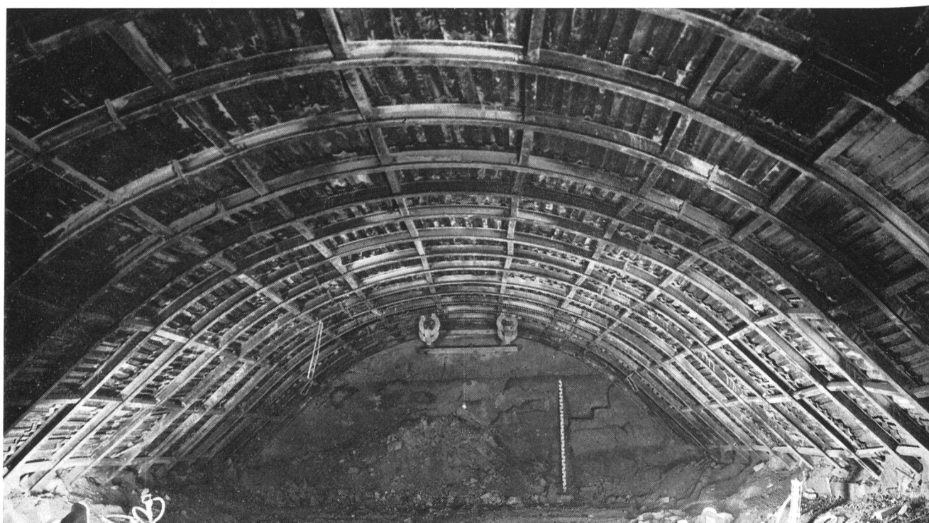
Stahleinbau im SBB-Bahntunnel Käferberg
