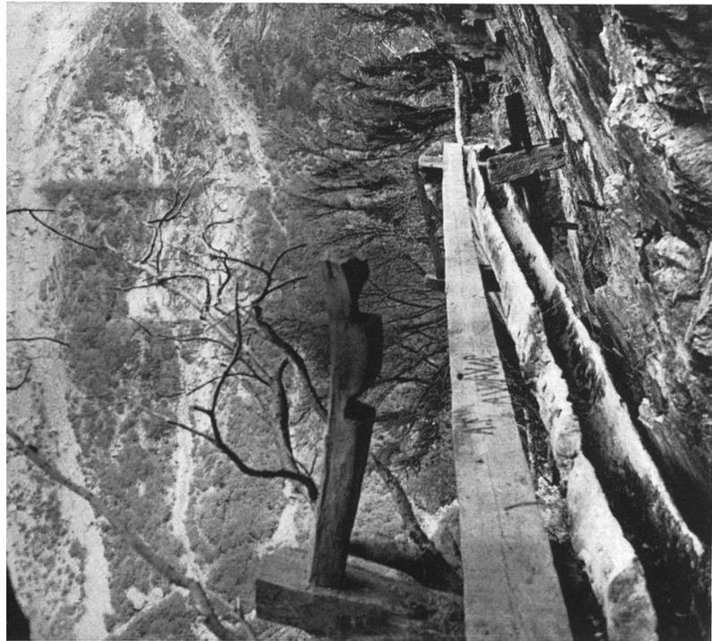
Fig. 3 Le bisse «Eggere» dans le Baltschiederthal. Cette conduite d'eau a été construite au 16<sup>e</sup> siècle et se compose par endroits de troncs de mélèzes évidés. La passerelle — simple planche posée sur les supports de la conduite — est indispensable pour le passage du garde-bisse au-dessus de l'abîme.
