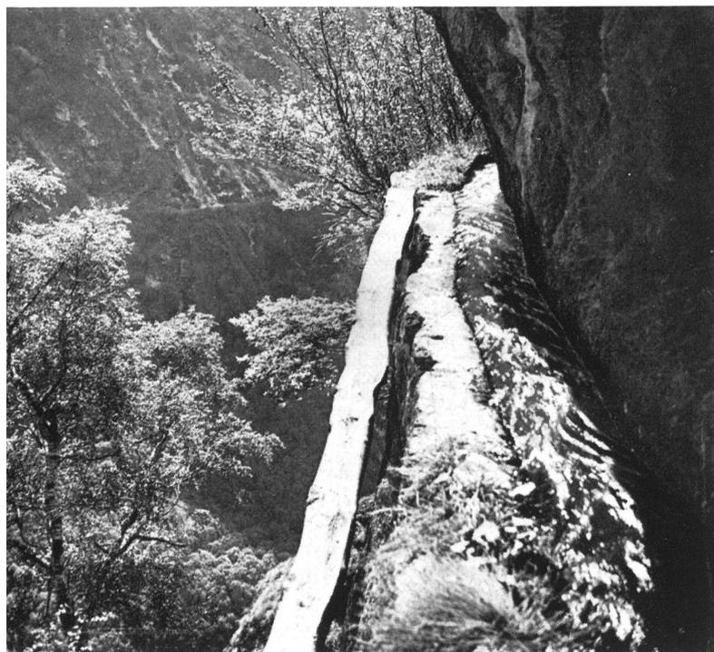
Fig. 2 Le bisse de Neuwerk, long de 14 km, dans le Baltschiederthal. Il emprunte ici une étroite corniche. Le rocher en surplomb ne permettant pas de passer sur la banquette du bisse, on a construit une passerelle rudimentaire pour le garde-bisse, faite d'une simple poutre glissante retenue aux extrémités par des arbustes.
