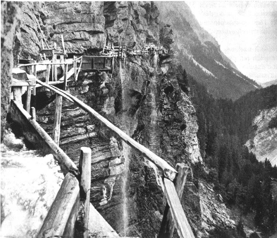
Fig. 4 Bisse suspendu, avec passerelle et chéneau, pour gros débit. Le bisse du Torrent-Neuf, à Savièse, accroché depuis le 16<sup>e</sup> siècle à la paroi des Branlires.
