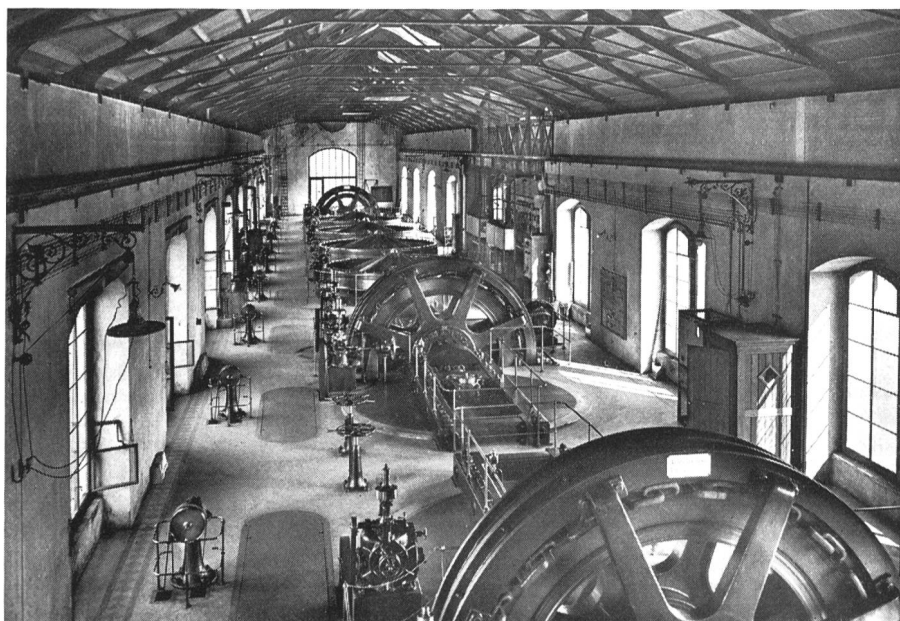
Fig. 2 Kraftwerk Ruppoldingen; Maschi- nensaal vor dem Umbau
