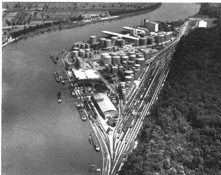
Fig. 4 (Photo Comet Zürich) Au-Hafen Baselland mit Tankfeldern Le port de Au, Bâle Campagne, avec les dépôts de carburant The Au harbour in Basle, with the oil tanks
