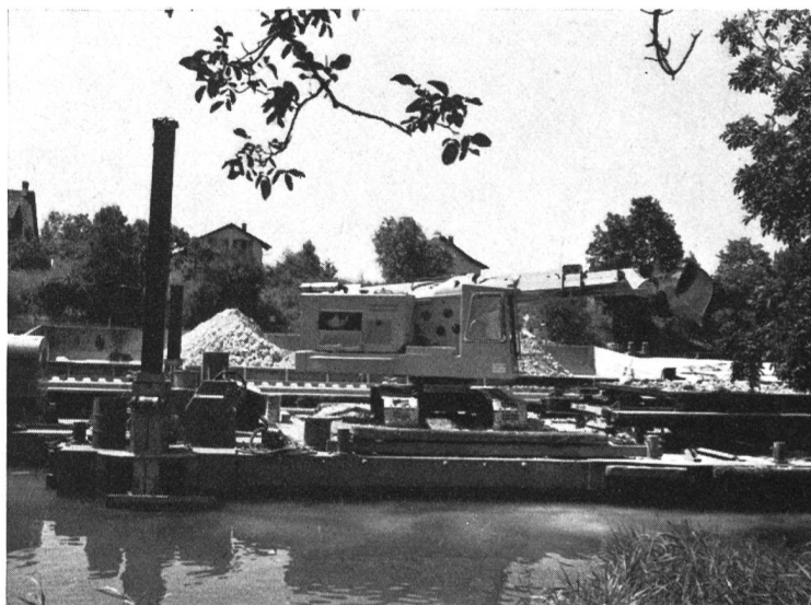
Fig. 5 Nidau-Bürenkanal. Einbringen des Steinmaterials für den Uferschutz mittels des Versetzschiffes, auf welchem ein in Quer- und Längsrichtung beweglicher, mit Bodenklappen versehener Versetzwagen montiert ist. Das Steinmaterial wird mit dem Teleskopbagger «Gradall» vom Transportschiff auf den Versetzwagen geladen, worauf es durch das automatische Öffnen der Bodenklappen in gewünschter Schichtstärke auf die Uferböschung fällt.
