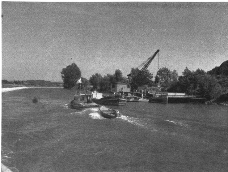
Fig. 10 Baggerung mit Dragline für die Verbreiterung des Broyekanal am rechten Ufer beim Neuenhof, mit Verlad in eine Klappschute.
