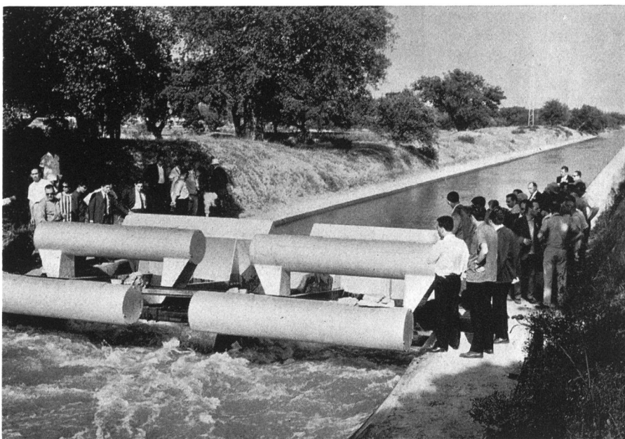
Fig. 5 Hauptzuleitungskanal im Miragebiet mit Stauregelung
