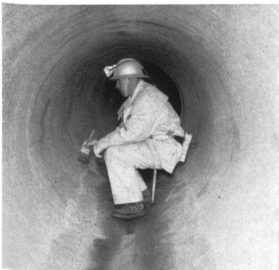
Beschichteter Stollenabschnitt nach dem Auskleiden mit «Cital-Aquapaint»
