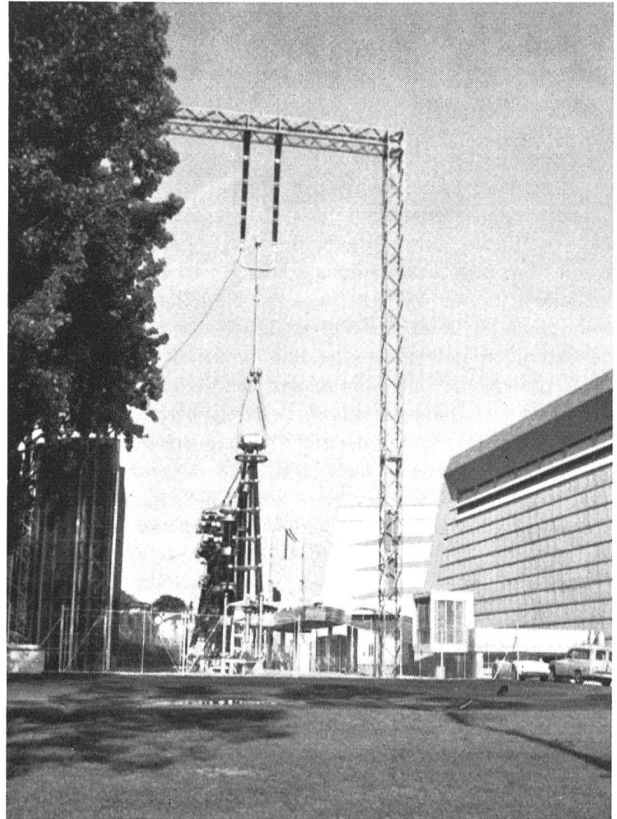
Fig. 6 Teilansicht einer im Sektor «Industrie und Gewerbe / Abt. Energie» erstmalig in Betrieb gezeigten 750 000 Volt-Schaltanlage
