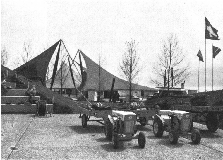
Fig. 3 Am Pressetag, zwei Tage vor Eröffnung der Expo, waren noch etliche Arbeiten fertig zu stellen
