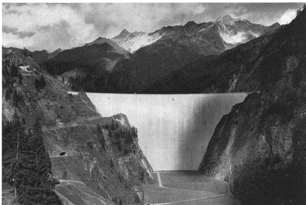
Fig. 1 Die 208 m hohe Bogenstaumauer Luzzzone gehört zu den grössten Talsperren der Schweiz
