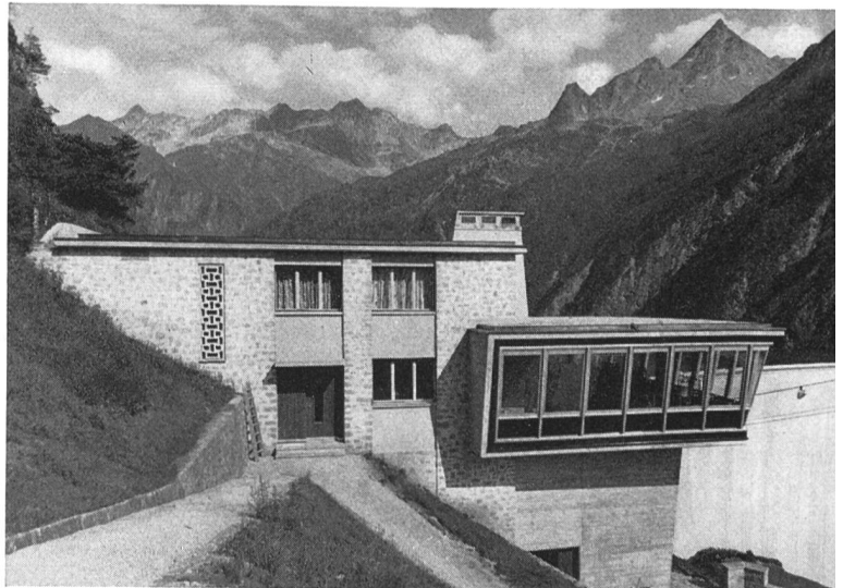
Fig. 2 Originell gestaltetes Wärterhaus mit Restaurant in der schönen Aussichtsterrasse; das Gebäude dient gleichzeitig als Bergstation der Seilbahn Olivone–Luzzone
