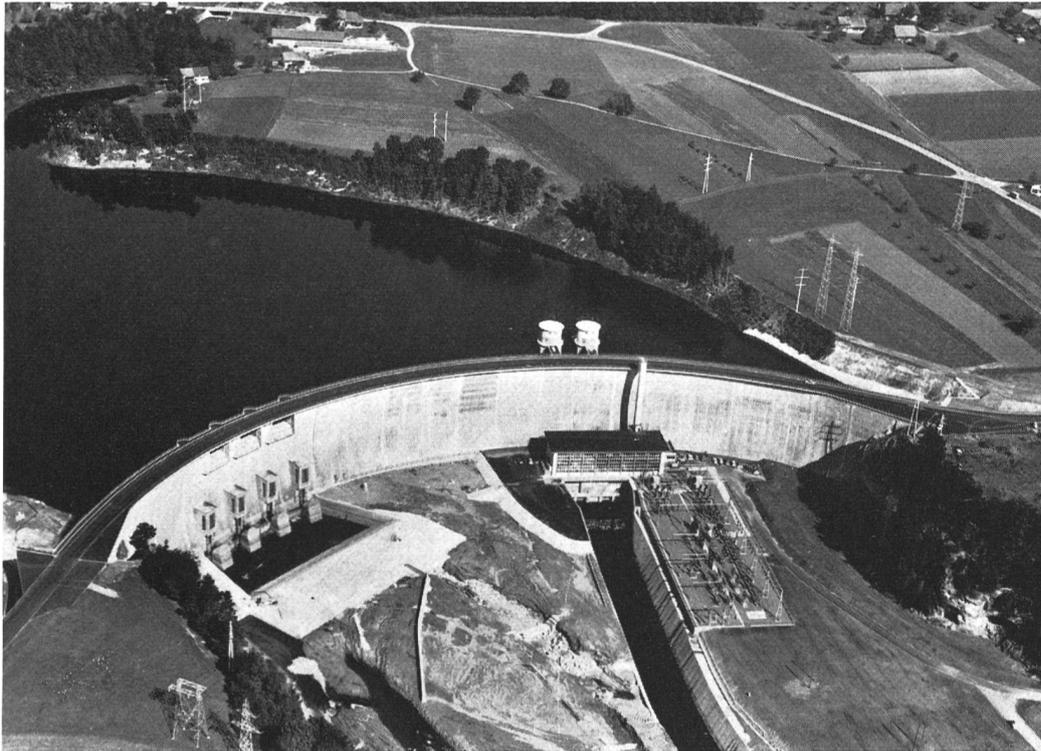
Staumauer und Stausee Schiffenen an der Saane; Kraftwerk und Schaltanlage am Fuss der Talsperre
