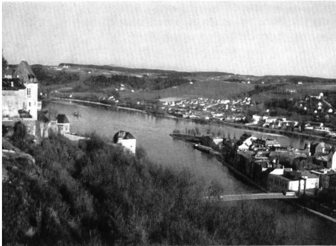
Bild 9 Der Zusammenfluss von Donau und Inn mit der äussersten Spitze der Stadtsiedlung von Passau; links die Feste Oberhaus.
