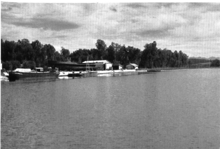
Bild 6 Umschlagstelle Sugiez am Broye-Kanal, unweit des Murtensees, mit kleiner Werftanlage, wo zur Zeit ein ansehnlicher Lastkahn gebaut wird.
