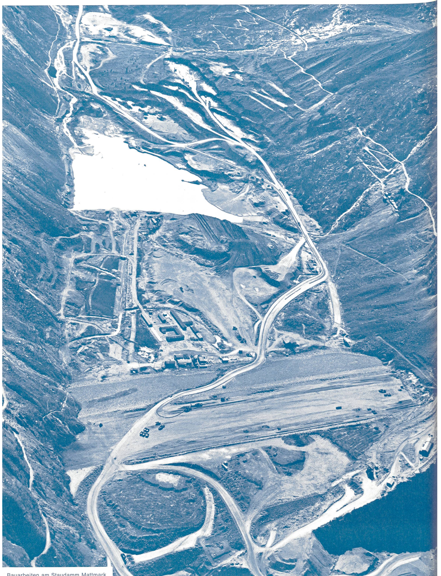
Bauarbeiten am Staudamm Mattmark
