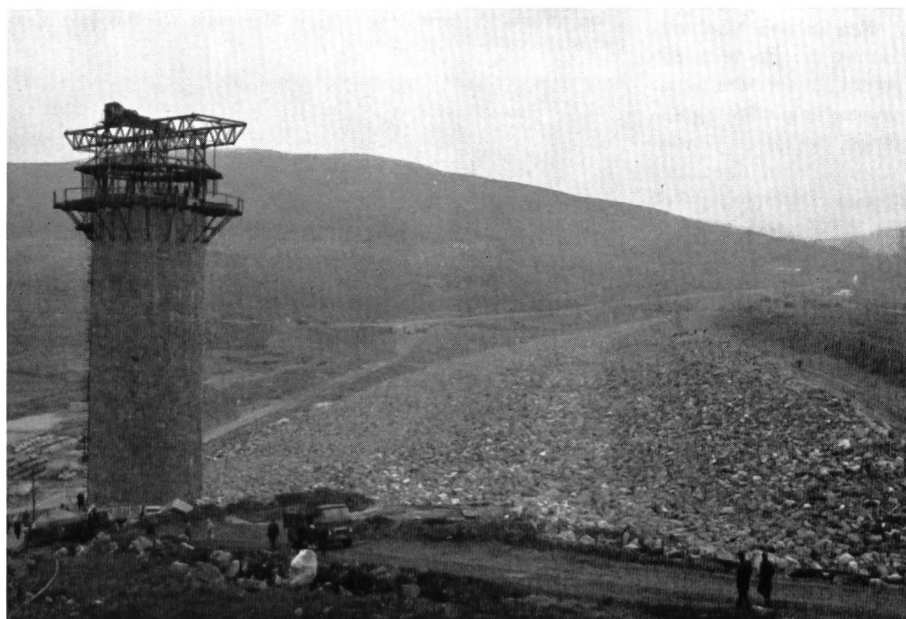
Bild 14 Im Bau befindlicher Wasserfassungsturm und Erddamm Tryweryn in Nordwales
