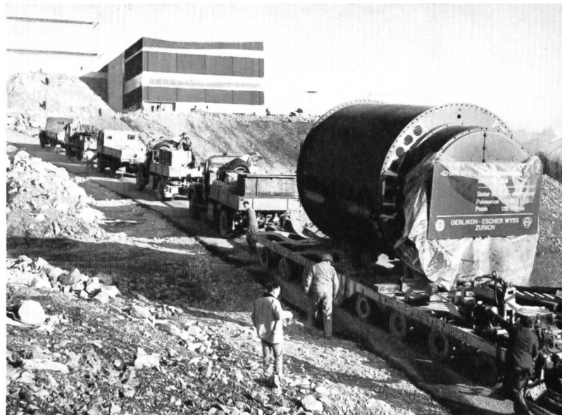
Bild 1 (oben) So wurde die 15prozentige Steigung vor dem Kraftwerk bewältigt. Mit 5 Camions vor und 2 hinter dem Tieflader mit dem Stator bewegte sich die Riesenschlange auf das Maschinenhaus des Kraftwerkes Chavalon zu.
