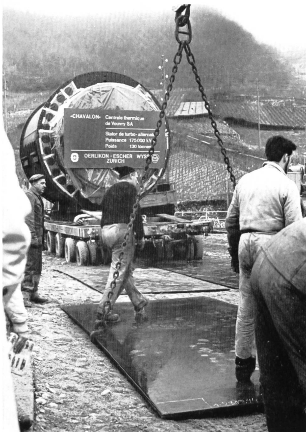
Bild 1 (oben) So wurde die 15prozentige Steigung vor dem Kraftwerk bewältigt. Mit 5 Camions vor und 2 hinter dem Tieflader mit dem Stator bewegte sich die Riesenschlange auf das Maschinenhaus des Kraftwerkes Chavalon zu.
