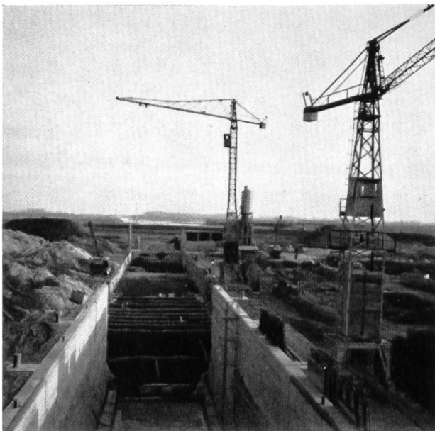
Fig. 3 Porto Interno di Cremona, biconca a Po; situazione lavori al Novembre 1963
