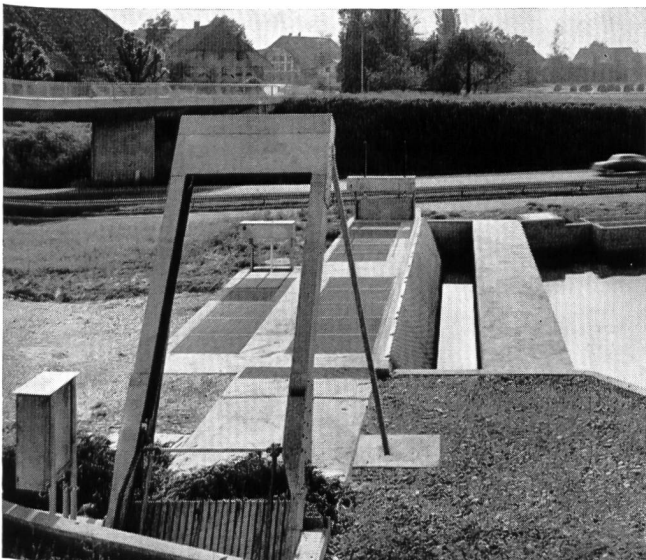
Von uns kürzlich an Autobahnstrecke gelieferte Anlage
