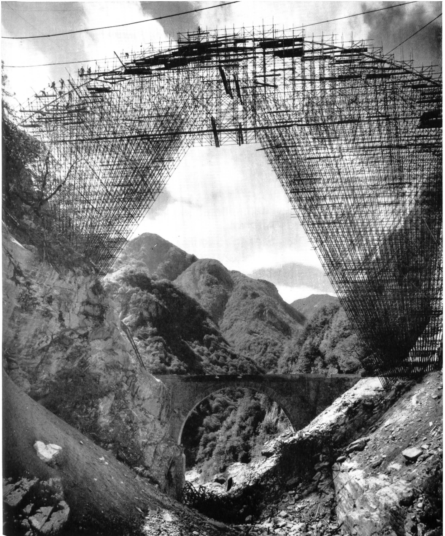
Lehrgerüst Val Porta, Verzasca-Tal TI
