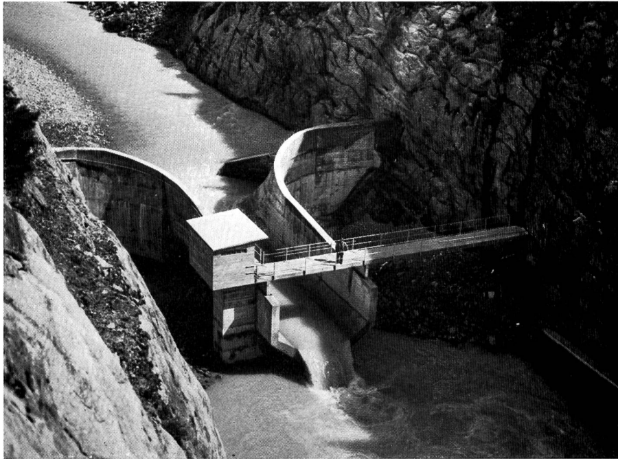
Bild 2 Wassermess-Station an der Massa, Blick von Unterwasser
