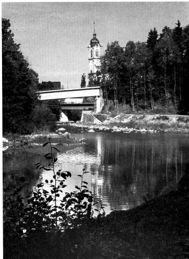
Bild 3 Aufgestaute Sihl unterhalb Schindellegi
