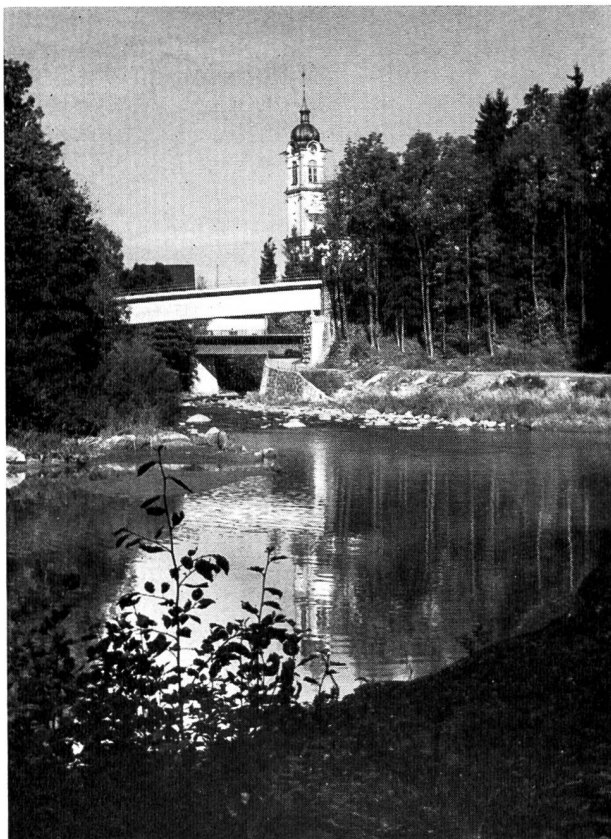
Bild 3 Aufgestaute Sihl unterhalb Schindellegi
