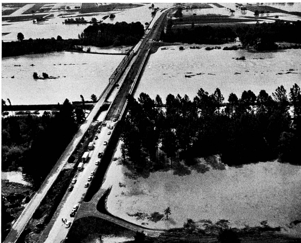
Bild 3 Thurbrücke bei Pfyn
