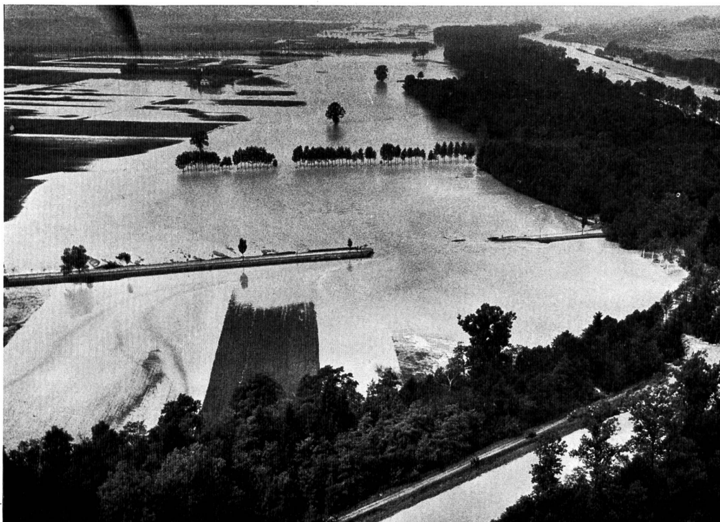
Bild 1 Dammbruch an der Murg vor ihrer Einmündung in die Thur und Bruch der Strasse Frauenfeld- Weiningen
