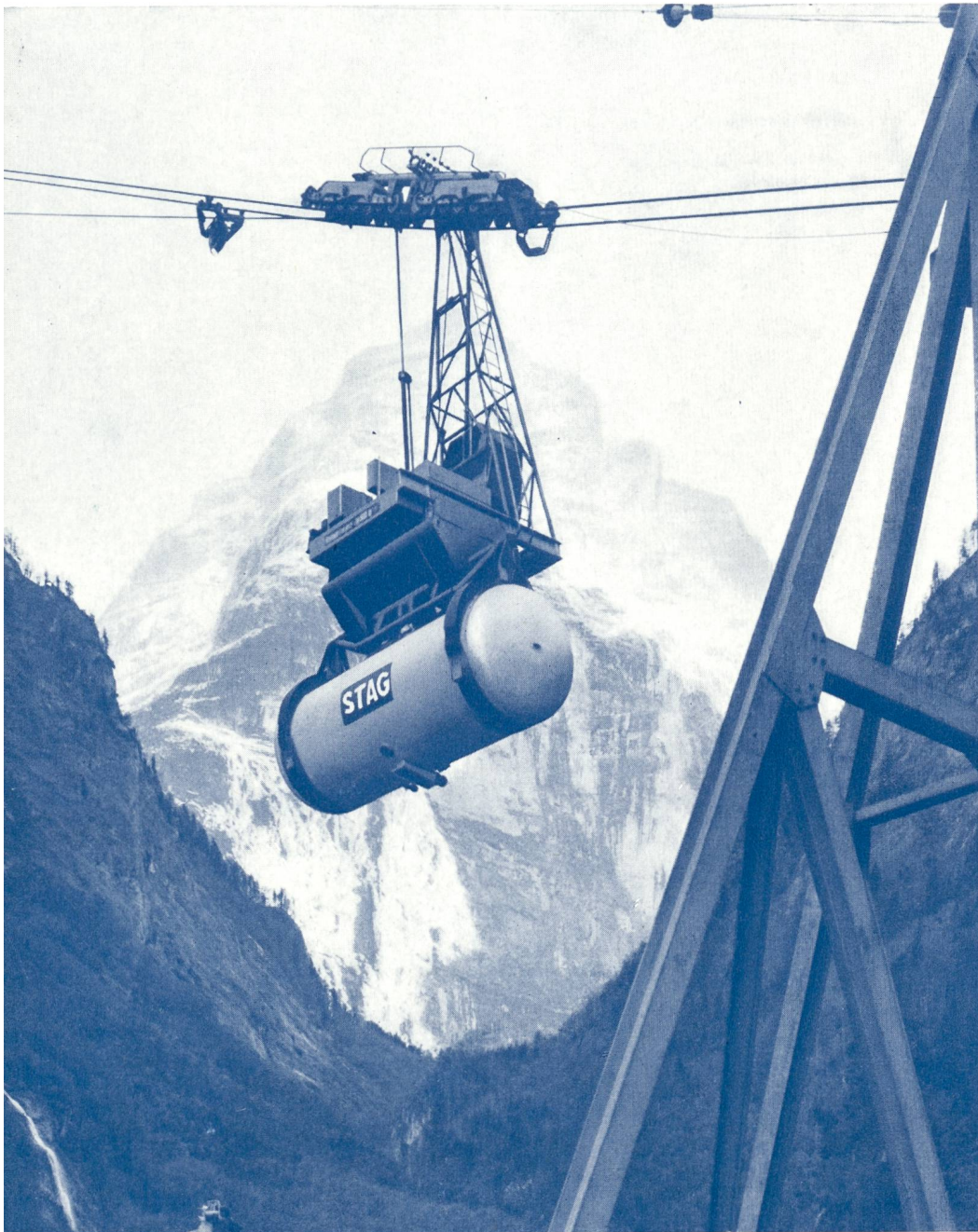
Aluminium-Behälter STAG an der Schwereiseilbahn der KW Linth-Limmern, Fassungsvermögen 16 t Zement
