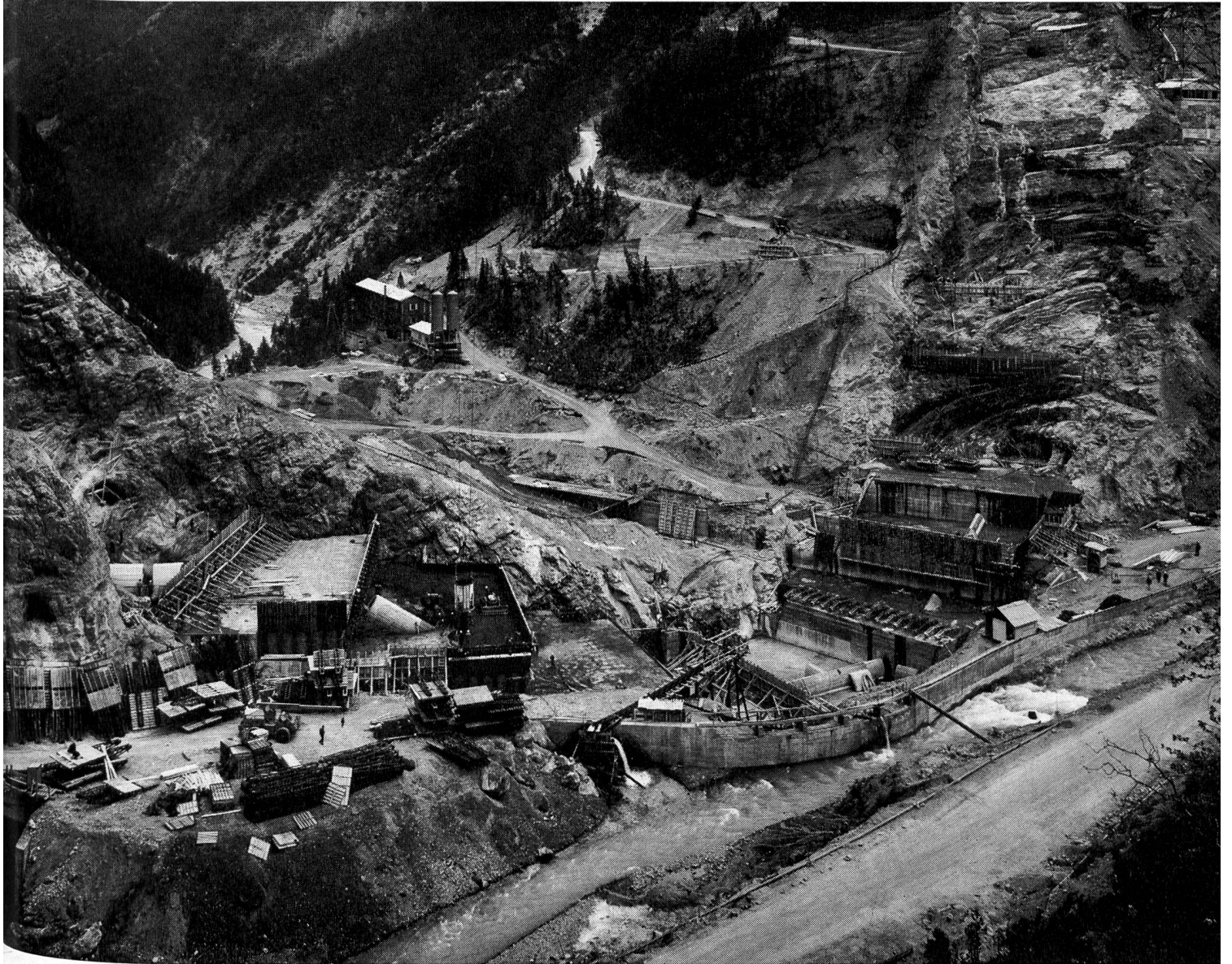
Baustelle der Staumauer Punt dal Gall der Engadiner Kraftwerke. Beginn der Betonierungsarbeiten in der Baugrube. Stand Juni 1966.
