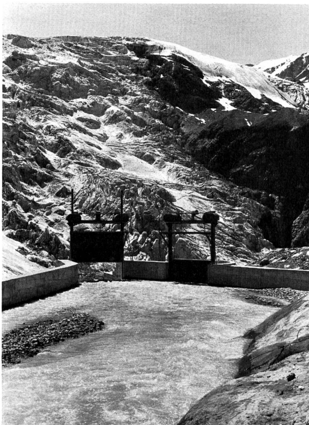
Bild 6 Wasserfassung des Wildbachs aus dem oberen Arollagletscher mit Mont Collon-Gletscher im Hintergrund.
