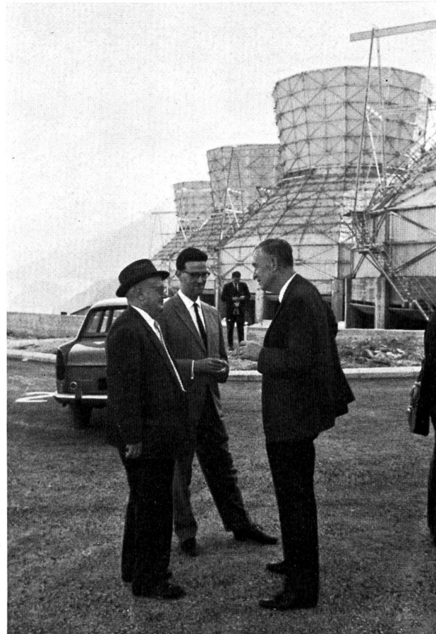
Bild 5 Die Kühltürme des thermischen Kraftwerks; vorn die Herren Manfrini, Babaianz und Binkert.
