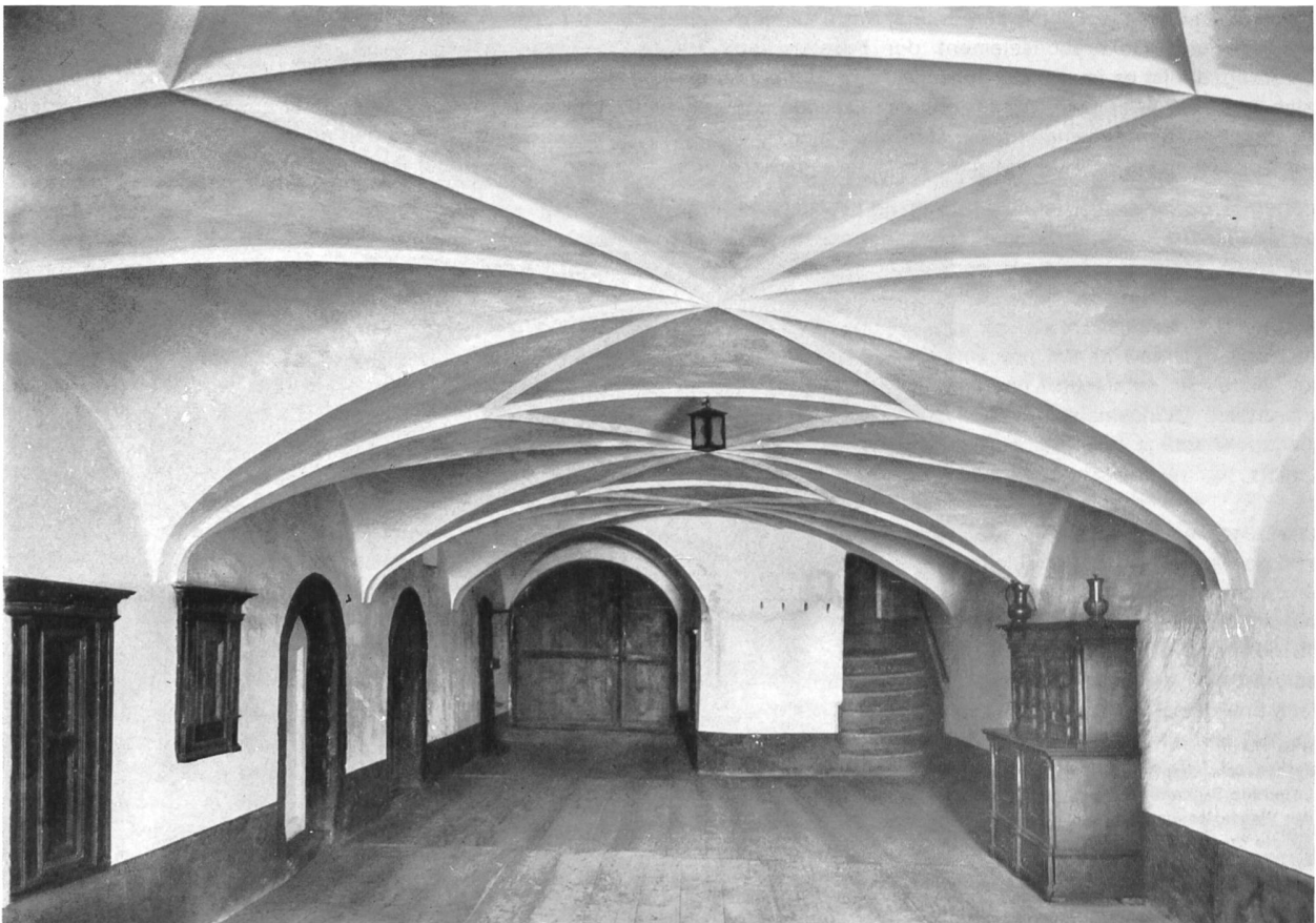
Bild 117 Beispiel eines der noch zahlreichen gewölbten Sulërs, eines typischen Bestandteils des Engadinerhauses. Durch diesen Gang können die hochbeladenen Heufuder durch die gewölbten Tore in den Heustall geführt werden. Haus in La Punt, erbaut um 1600
