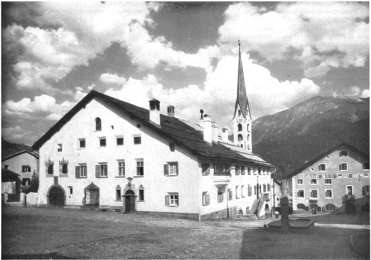
Bild 116 Das berühmte grosse Plantahaus in Zuoz, dominierendes Gebäude im früheren Hauptort des Oberengadins. Typisches Beispiel eines stolzen, mächtigen Patrizierhauses mit schönen schmiedeisernen Gittern und monumentaler barocker Treppe zum Haupteingang
