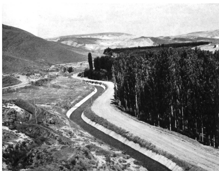
Bild 14 Wasserzuleitung zum Ulnumak-Bewässerungsgebiet bei Konya (ca. 13 400 ha).
