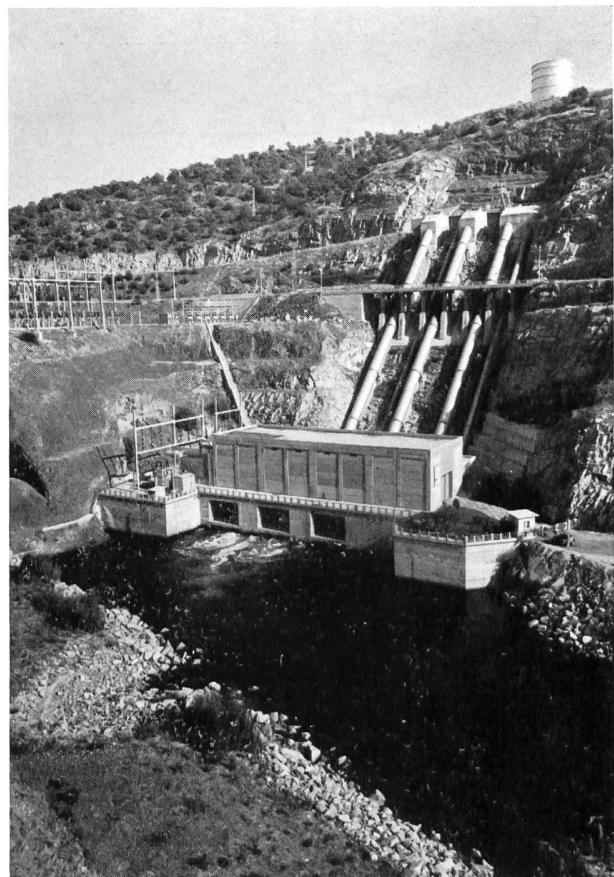
Bild 15 Kraftwerk Demirköprü am Gediz. Installierte Leistung 3 x 23 000 kW.
