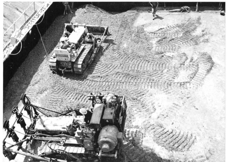
Bild 16 Verteiler und Rüttler beim Einbau des Betons für die Talsperre Punt dal Gall.
