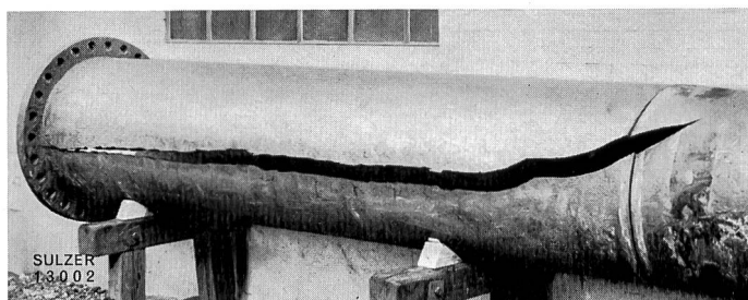
Bild 1 Rohrbruch einer wassergasgeschweissten, im Jahre 1908 erstellten Verteilleitung.
