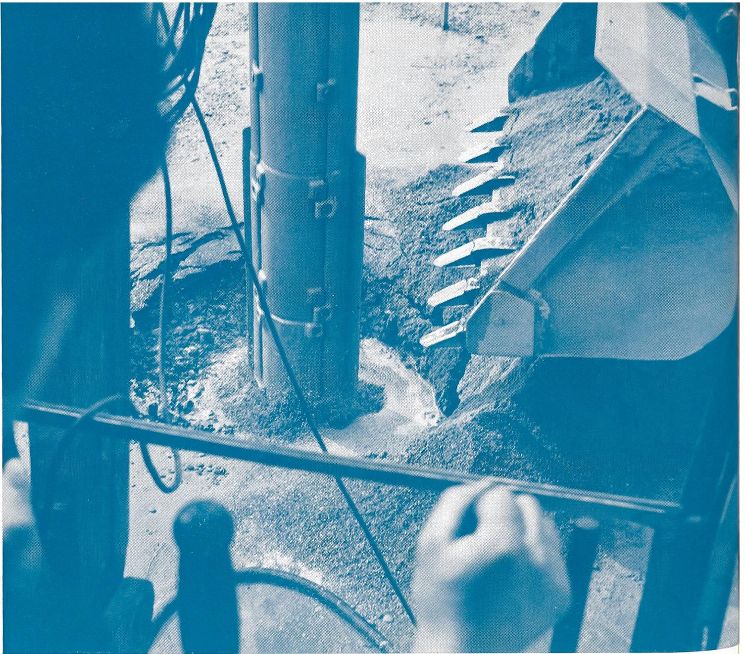
Tiefenverdichtungen nach dem **Rütteldruckverfahren**. Zur Erhöhung der Tragfähigkeit anstehender Böden oder künstlicher Aufschüttungen. Zur Reduktion der Wasserdurchlässigkeit (k-Wert) grobdurchlässiger Kiese und Kiessande.
