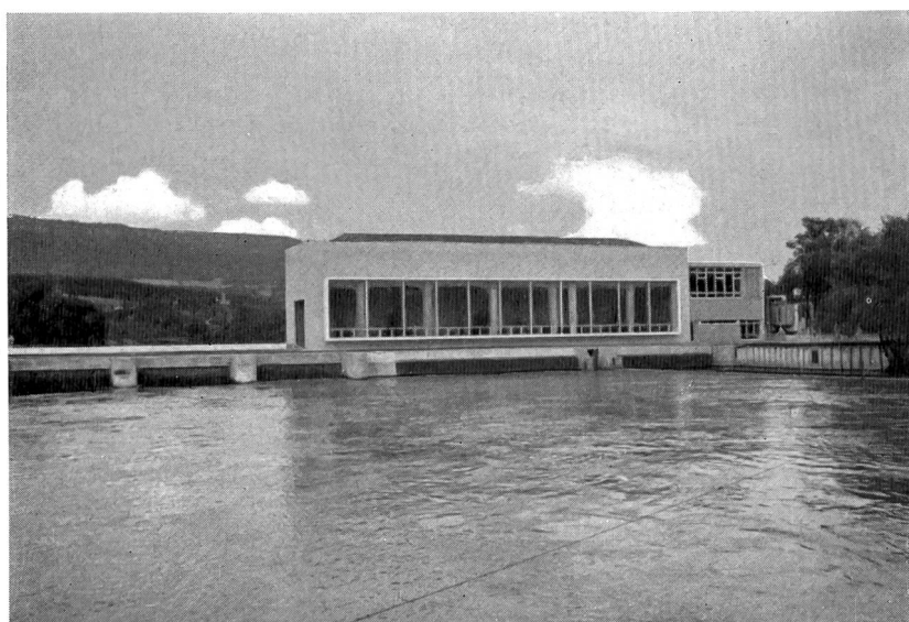
Bild 9 Das ebenfalls noch im Bereich der Stadt Aarau gelegene Aarekraftwerk Rühlig der Juracement-Fabriken AG. Diese 1927/28 erstellte Anlage wurde 1961/62 teilweise erneuert, wobei hier in der Schweiz erstmals grössere Rohrturbinen zur Anwendung gelangten. Ansicht vom Oberwasser; rechts Maschinenhaus mit den ursprünglichen Einheiten, in der linken, wenig über den Wasserspiegel aufragenden Konstruktion sind die neuen Rohrturbinen installiert. (Photo G. A. Töndury)
