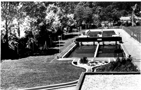
Bild 5 Kläranlage Mittleres Wynental. Von vorn nach hinten: Vorklärbecken, Belüftungsbecken, Nachklärbecken.
