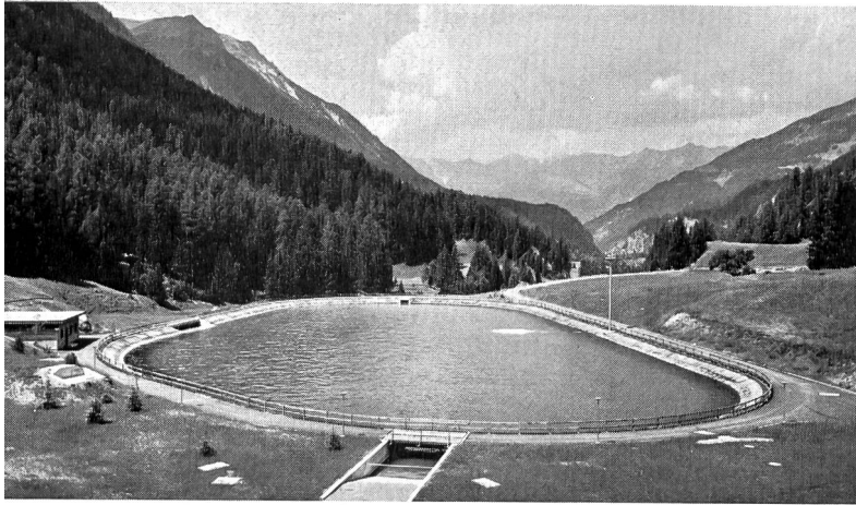
Bild 2 Ausgleichbecken Islas oberhalb Bergün mit 35 000 m 3 Nutzinhalt; Blick talabwärts
