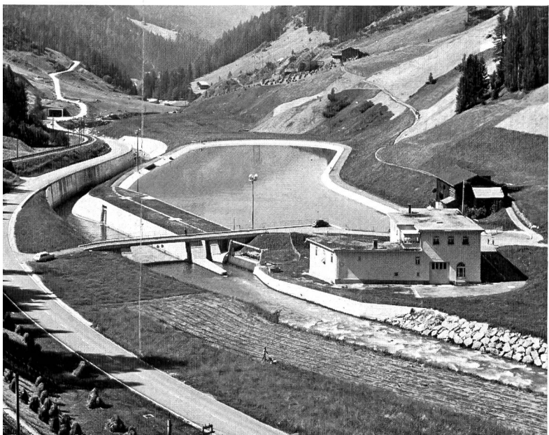
Bild 4 Ausgleichbecken Glaris-Ardüs mit 50 000 m 3 Nutzinhalt; im Vordergrund die Zentrale des Kraftwerkes Glaris des EW Davos
