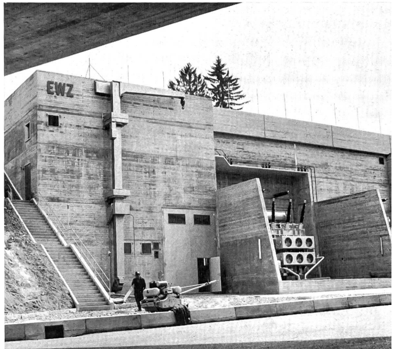
Bild 2 (rechts oben) Autobahnseitige Fassade des Unterwerks Frohalp mit zwei 16-MVA- Transformatoren
