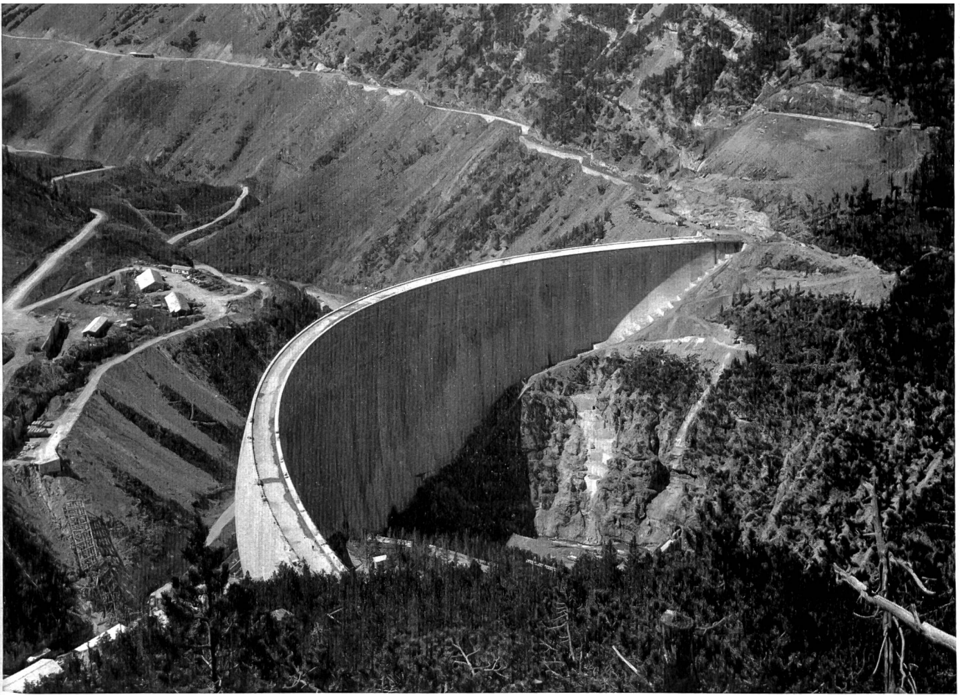
Staumauer Punt dal Gall der Engadiner Kraftwerke
