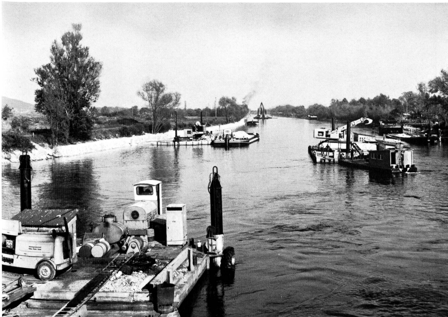
Bild 6 Die Arbeitsfront im Nidau-Bürenkanal.
