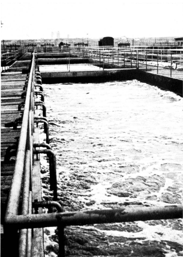
Bild 9 Belüftungsbecken.
