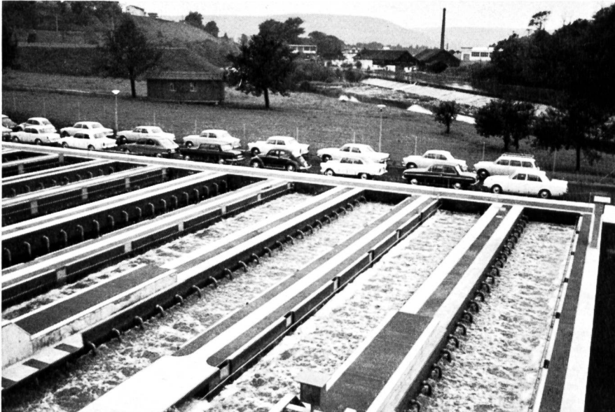
Bild 5 Blick auf einen Teil der Belüftungs- becken
