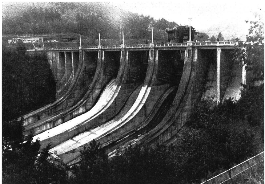
Bild 9 Talsperre Slapy an der Moldau in der CSSR; Hochwasserentlastung
