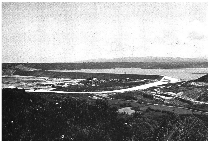
Bild 1 Stauanlage Pinios Ilias in Griechenland
