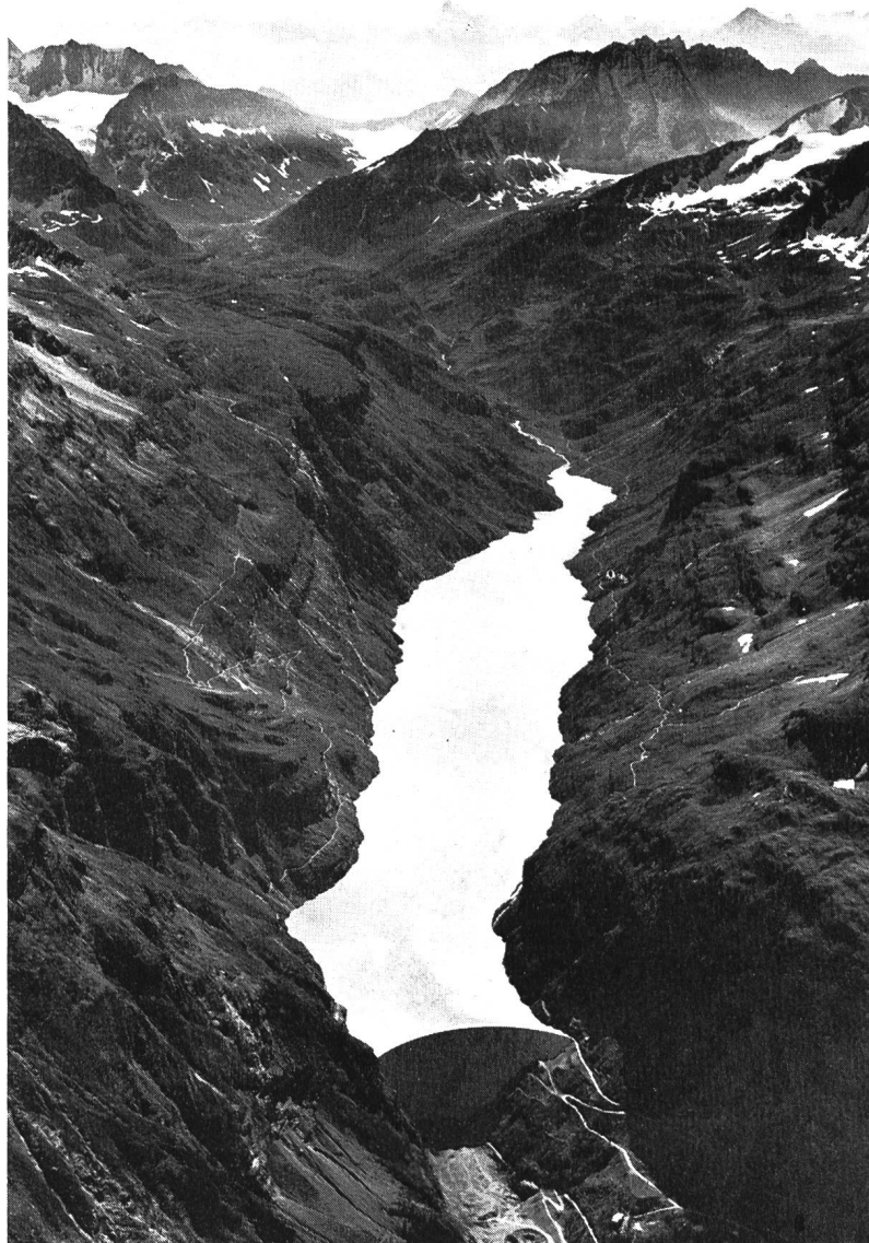
Bild 3 (rechts) Staumauer und Stausee Mauvoisin auf 1962 m ü. M., mit 237 m die höchste Bogenstaumauer in der Schweiz (Photo F. Engesser, Feldmeilen)
