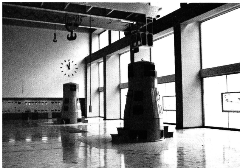
Bild 4 In der schönen Talsperrenzentrale Ova Spin
