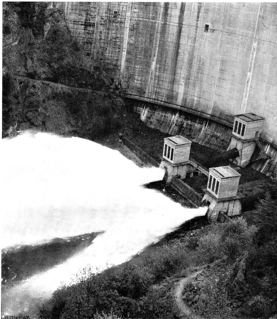
Zwei Grundablässe am Fuß der Staumauer Rossens (Freiburg, Schweiz) in voller Aktion. Lichte Weiten der Regulierschützen 1600 × 2900 mm. Maximale Abflußmenge beider Ablässe 260 m<sup>3</sup>/s bei einem Druck von 66 m WS.
