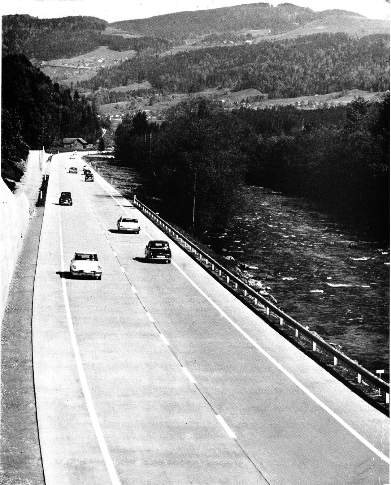
T 10 Bern—Luzern, Umfahrung Malters, Betonbelag
