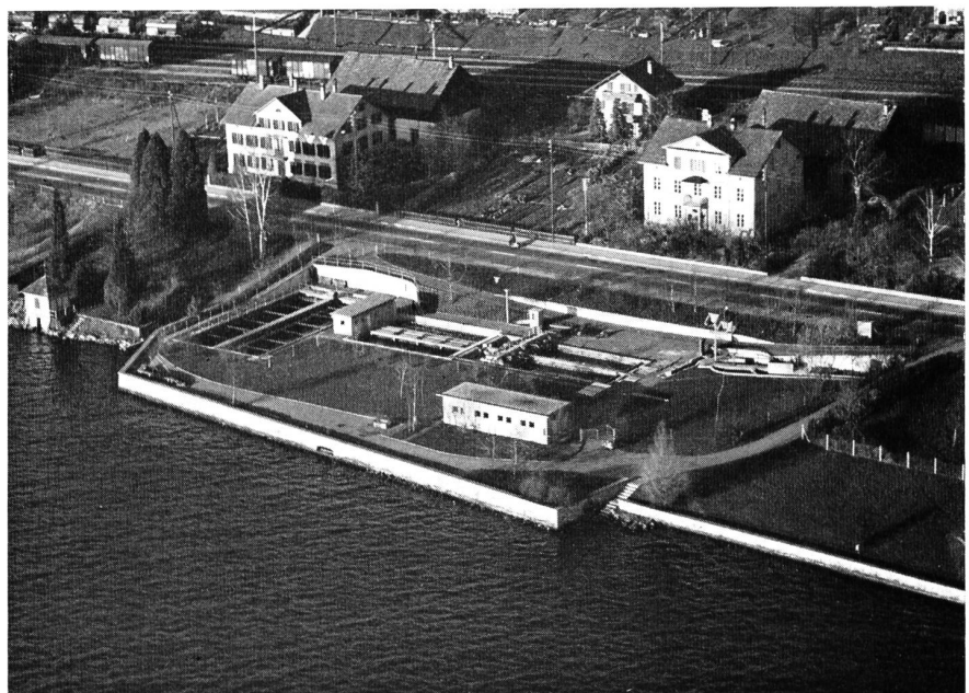
Bild 2 Kläranlage Männedorf am Zürich- see (für 65 l/s). Mechanisch-biologische Anlage nach dem Belebtschlamm- Verfahren
