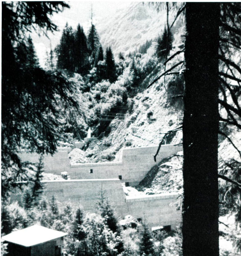
Bild 8 Zwei der neueren Sperren im oberen Tobel des Durnagelbaches.
