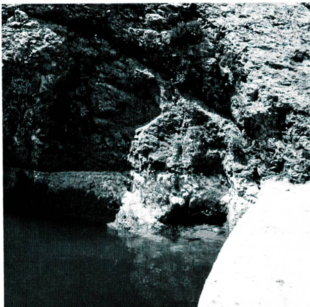
Bild 7 Die wasserseits des linken Kronenendes der Staumauer von 1891 im Vallon de Baume südlich von Saint-Rémy noch sichtbaren Teile der Fundamentschlitz einer römischen Bogenstaumauer.
