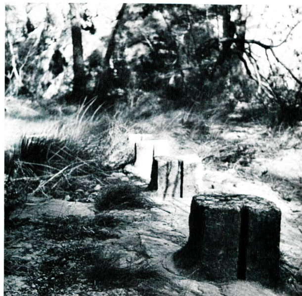
Bild 12 Ueberbleibsel des die «Petite mer» am Infernet aufstauenden, etwa 3 m hohen Wehres aus dem 17. oder 18. Jahrhundert; die Pfeiler mit Dammbalkennuten sind etwa 40 cm hoch.
