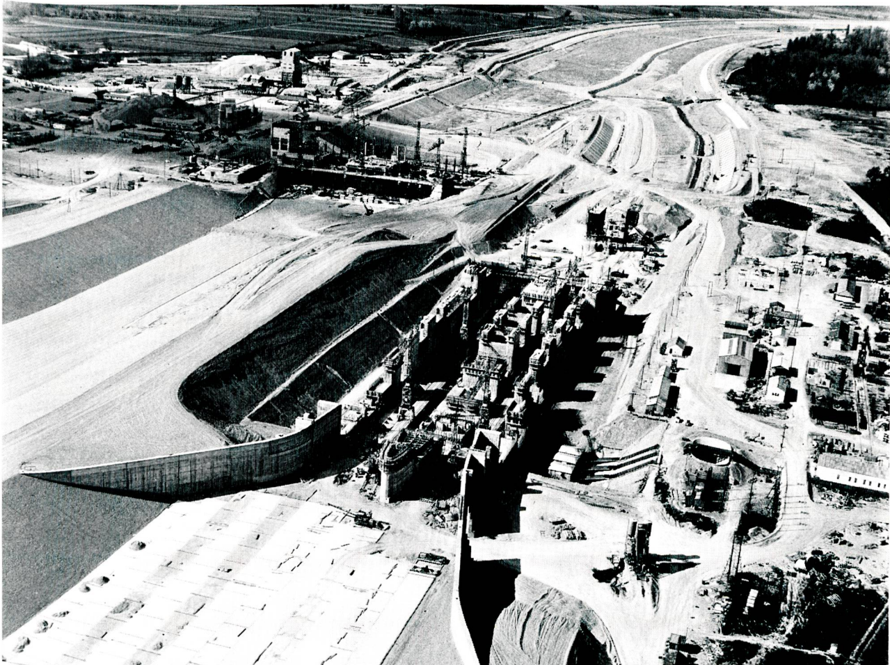
Figure 9 Vue aérienne des installations construites de 1959 à 1963 pour les écluses de navigation (au centre) et l'usine de Rhinau (en haut à gauche)
